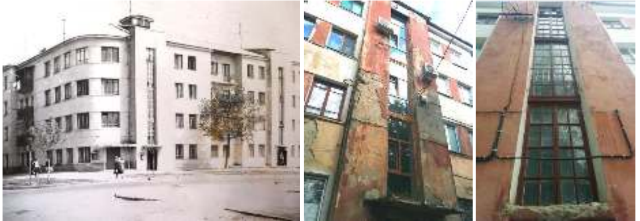
Figura A2.21. Locuință colectivă din strada A.Pușkin nr.20.
