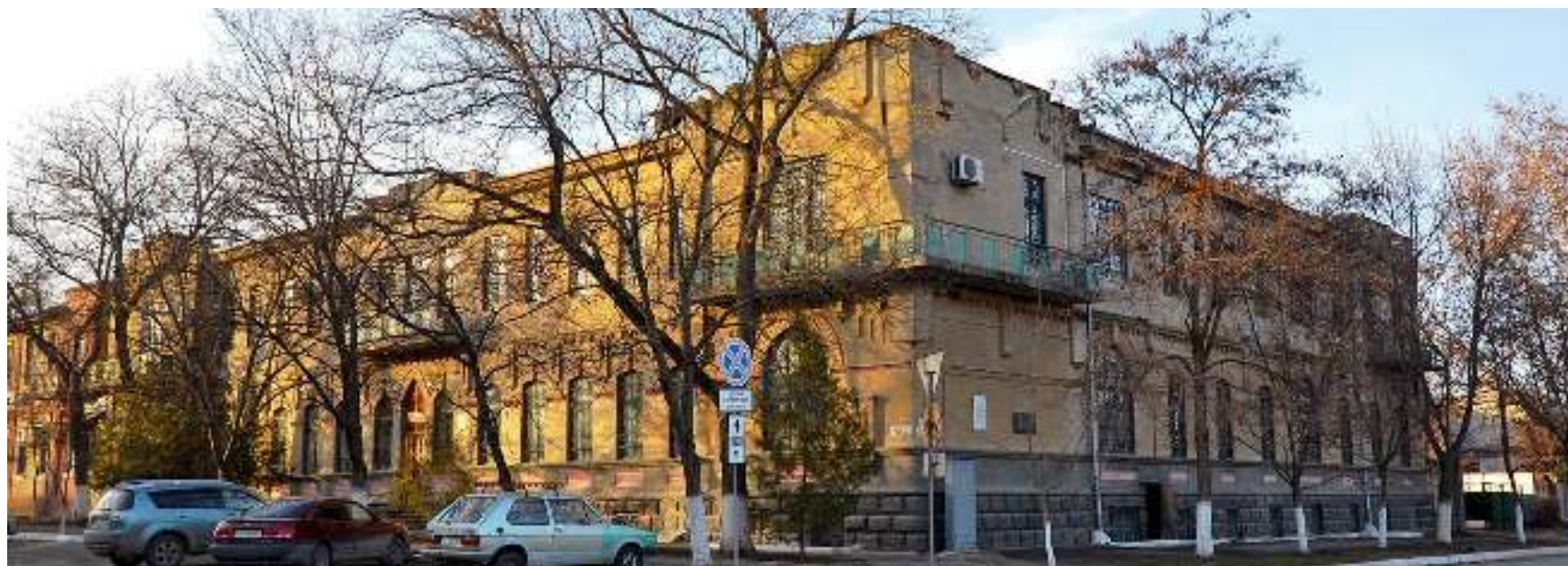
Figura A2.13. Casa zemstvei, actualmente Ministerul Sănătății și Protecției Sociale din RMN. Foto 04.02.2015 [43]
