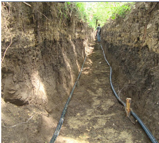
Fig.3. Fixarea conductelor conturului de extragere a c.p.r. în tranșee.
