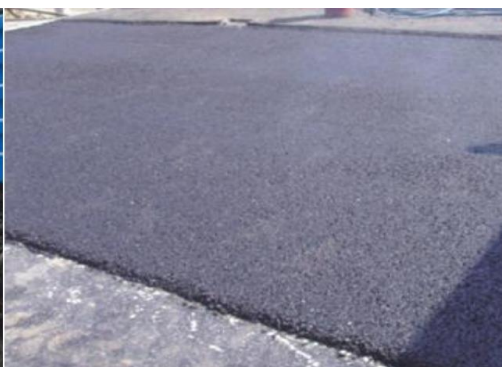
Figura 3. Stratul așternut prin tehnologia Novachip
