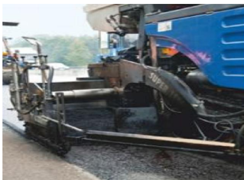
Figura 2. Așternerea mixturii bituminoase prin tehnologia Novachip
