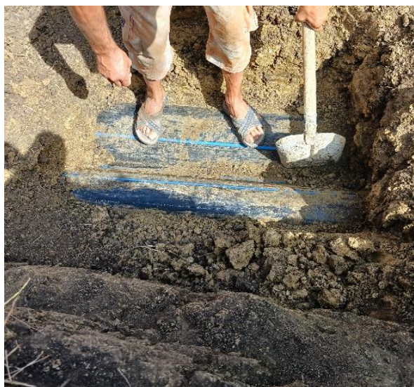
Foto 6. Vedere, pământ scos de pe suprafața tubului
