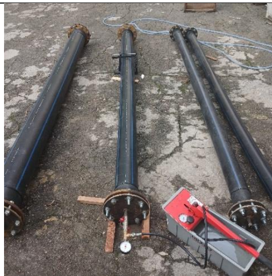
Foto 10. Restabilirea formei tubului cu pompa hidraulică
