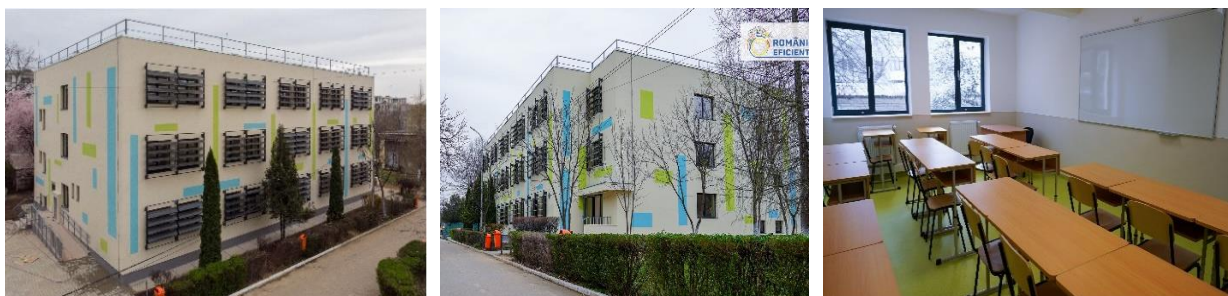
Figura 2. Clădirea Liceului Tehnologic Energetic “Elie Radu” din Ploiești
