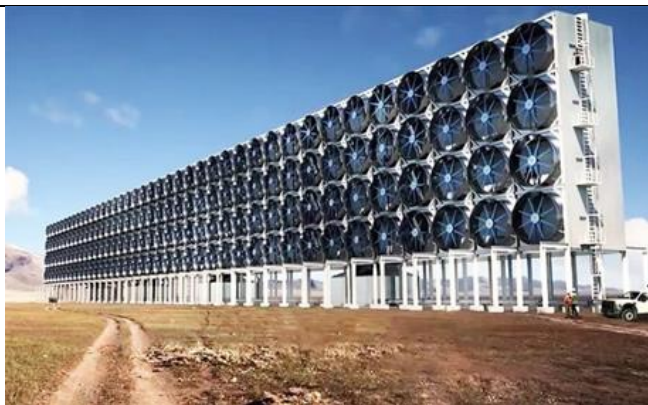
Figura 6. Instalații de captare a CO 2 din aer
