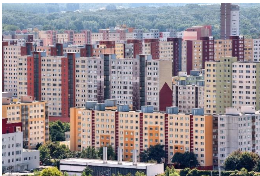
Figura 2. Cartier de locuințe din panouri prefabricate, reabilitat în conformitate cu cerințele ecologice și energetice din Slovacia [1].
