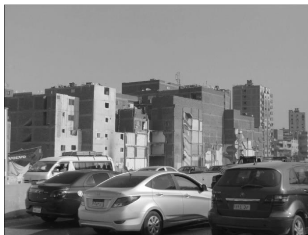
Figura 6. Demolarea construcțiilor aflate de-a lungul unui bulevard din Cairo (Egipt) pentru extinderea sa. Sursa imaginii: Alexandru-Ionuț Petrișor, 2021.
