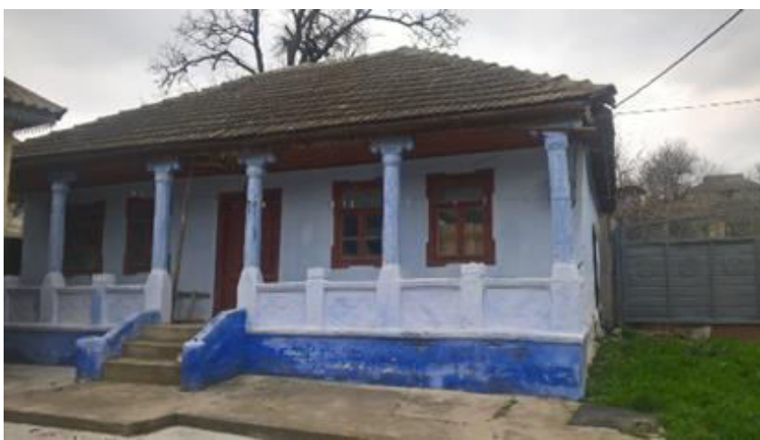
Figura 2. Casa construită în anul 1916 [6]
