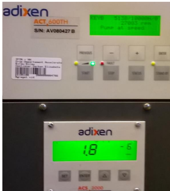
Fig. 2.20. Panoul de comandă al instalației de vacuum
