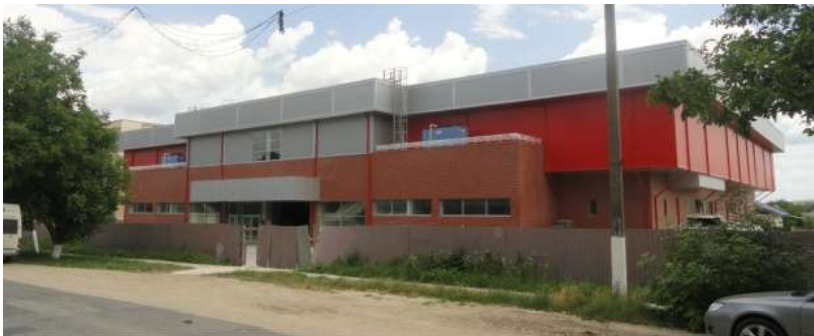
Fig. 12 Construcția în realitate
