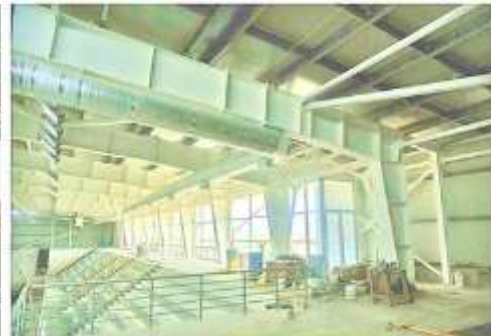
Fig. 13 Fotografie din interior a cadrelor metalice
