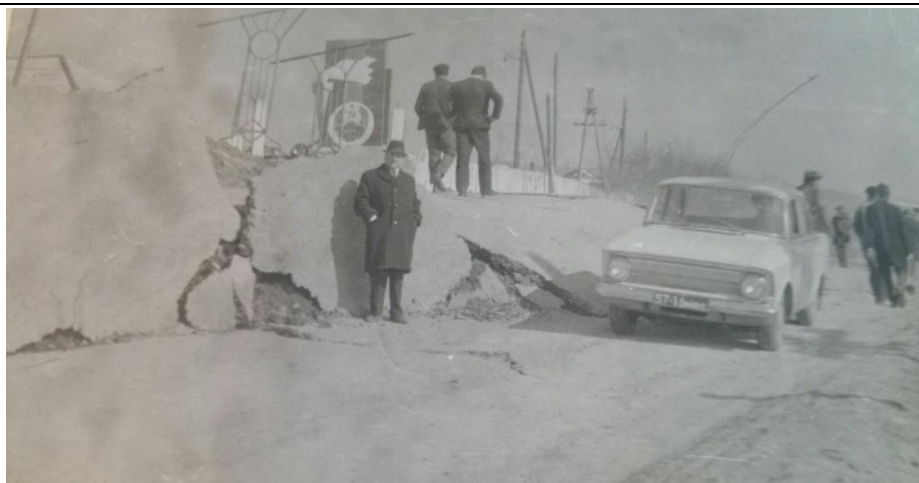
Figura 1. Rogacevschii I.A., conf. univ., dr. al departamentului GITF, în procesul realizării lucrărilor de prospecțiune geotehnică a drumului auto Chișinău-Leușeni, 1970.
