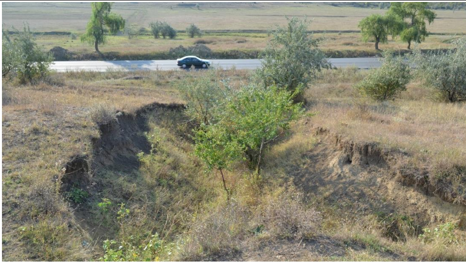
Figura 4. Deformațiile de alunecare pe versantul adiacent drumului național R2 Chișinău-Ungheni, 9 septembrie 2017 (foto realizată de Cîrlan A.)
