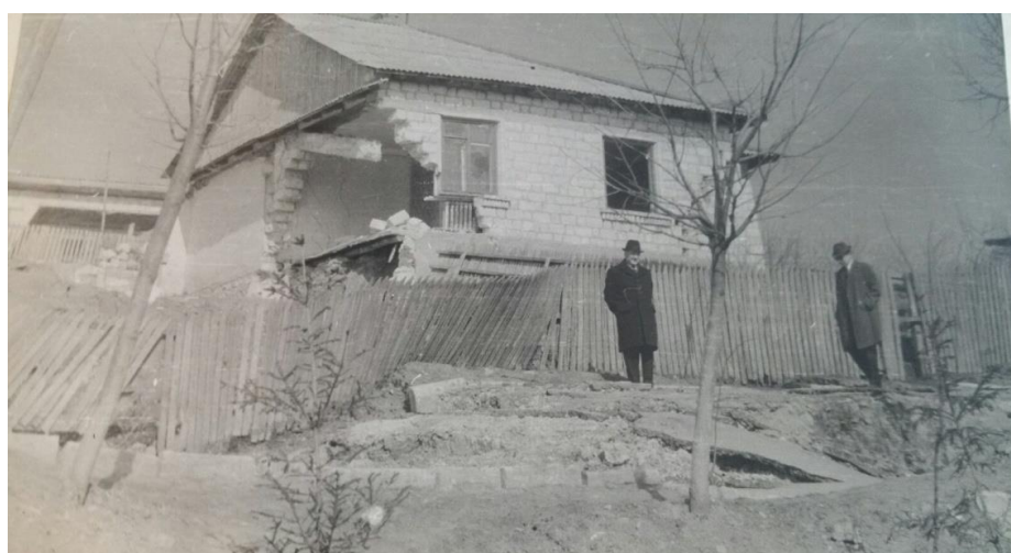
Figura 2. Rogacevschii I.A., conf. univ., dr. și Abramenco P.Gh., conf. univ, dr. al departamentului GITF, în procesul studiului tehnic și geotehnic al casei de locuit, distruse în urma alunecării de teren în raionul Hâncești, 1970.
