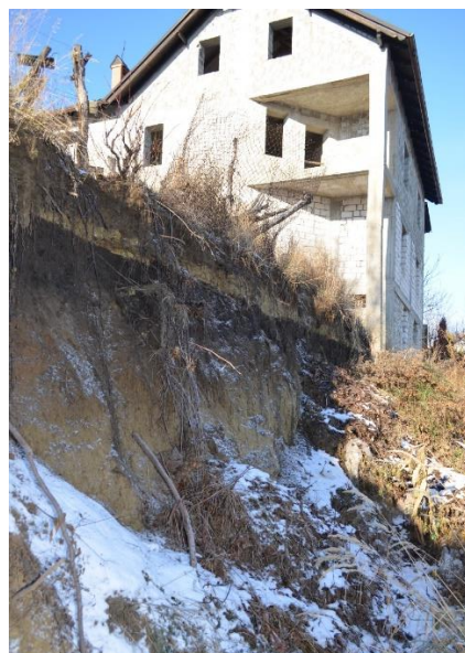
Figura 3. Afectarea structurii de rezistență a construcțiilor aflate pe versant alunecător, or. Codru, mun. Chișinău, 6 decembrie 2016 (foto realizată de Cîrlan A.)
