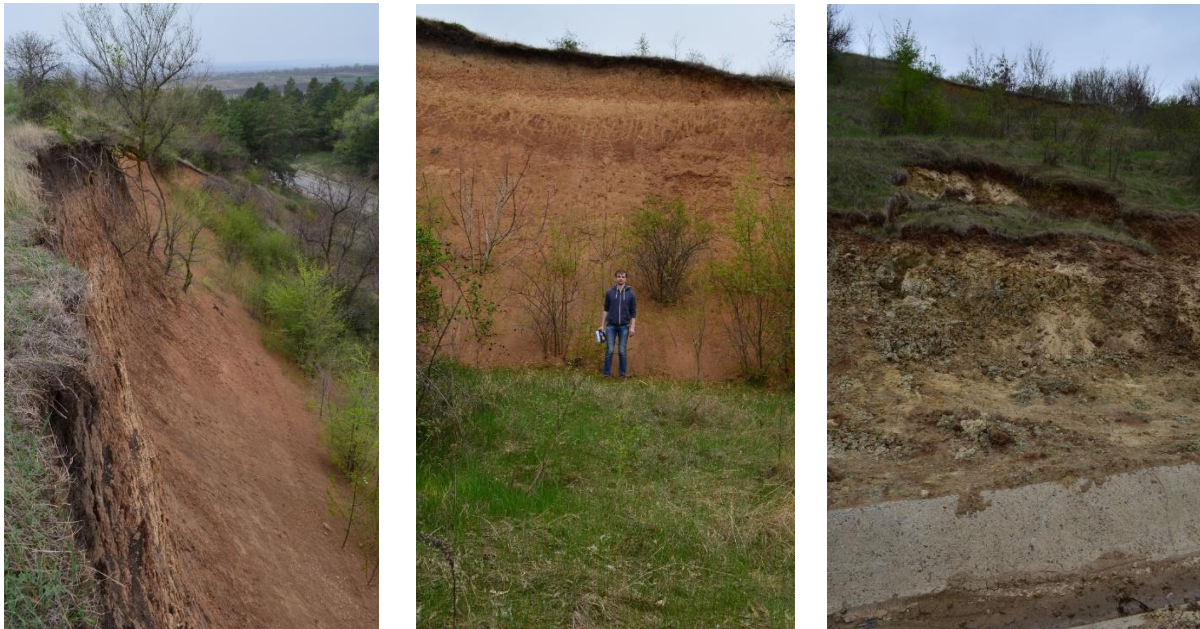
Figura 5. Expunerea straturilor de pământ argilo-nisipos pe taluzul debleurilor afectat de alunecări de teren, drumul național M21, aprilie 2017 (foto realizată de Cîrlan A.)
