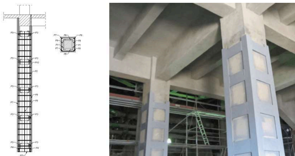
Figura 2. Utilizarea cornierelor și platbandelor sudate [2], [4]
