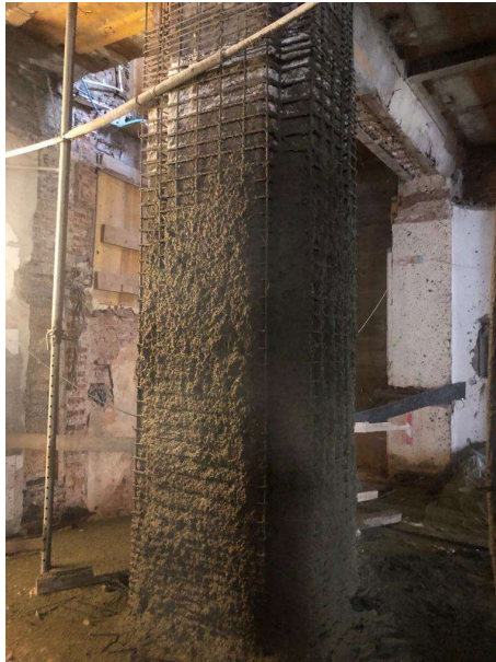
Figura 4. Aplicarea betonului prin torcretare[5]
