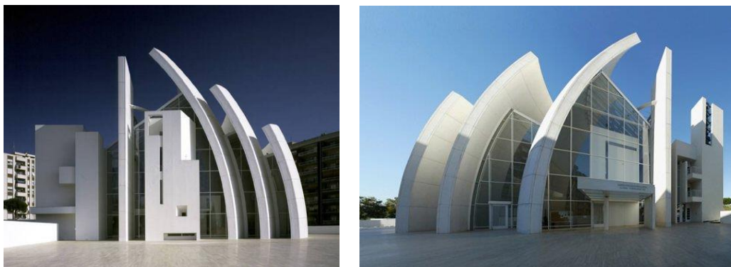
Biserica Jubileului din Roma, unul din cel mai des amintite succese în materie de construcții care folosesc betonul foto-catalitic cu aditivi din \text{TiO}_2 .
