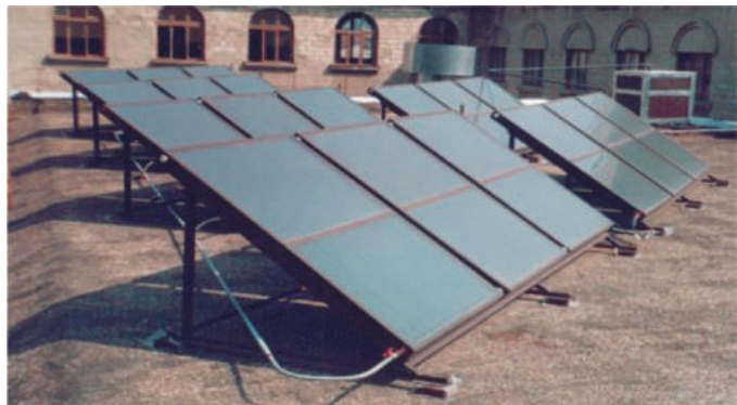
Fig. 1.47. Sistem solar pentru asigurarea cu apă caldă a camerelor de duș: Universitatea Cooperatist - Comercială din Chișinău.
