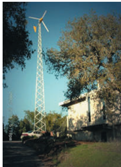
Fig. 4.45. Turbina Bergey Excel-S, 10 kW instalată în Scotts Valley, SUA.
