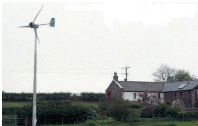
Fig. 4.46. Turbina eoliană AT5-1 Iskra instalată la școala din Redland, Marea Britanie.
