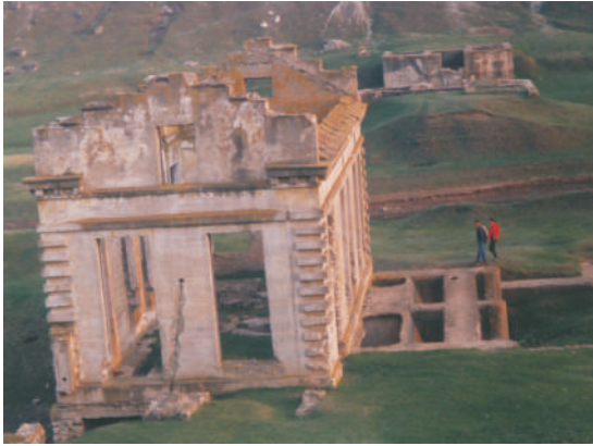
Fig. 1.62. Minihidrocentrală din comuna Piatra.
