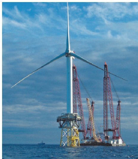
Fig. 4.36. Montarea turbinei eoliene cu puterea de 5 MW. Germania, coasta Mării de Nord.
