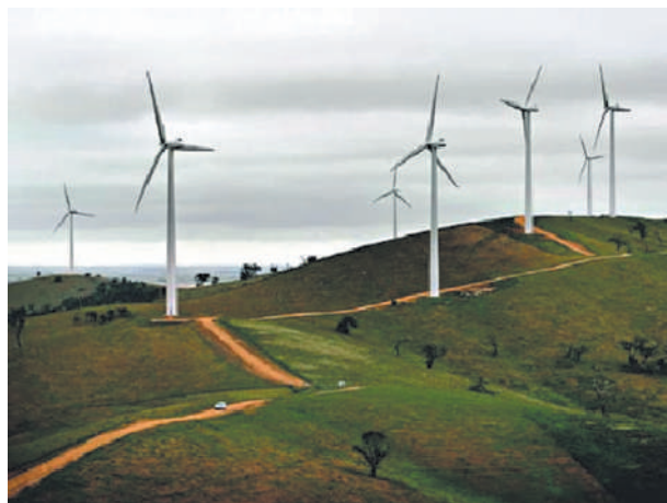
Fig. 4.41. Exemplu de fermă eoliană amplasată pe colinele Challicun, Australia [37].
