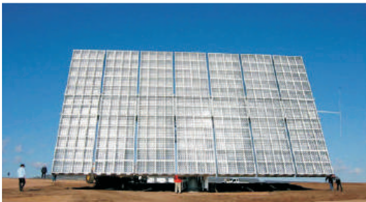
Fig. 2.92. Sistem Amonix cu concentrator cu lentile acrilice și celule PV din siliciu (Sursa: NREL).
