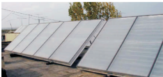
Fig. 2.31. Exemplu de sistem solar pentru încălzirea apei.
