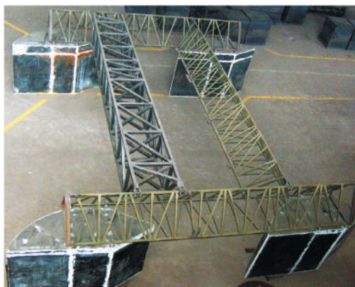
Carcasa spațială cu patru corpuri plutitoare aflată în stadiul de fabricare la întreprinderea „Incomaș” - SA, Chișinău.
