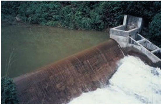
Fig. 3.14. Stație de măsurări hidrologice.
