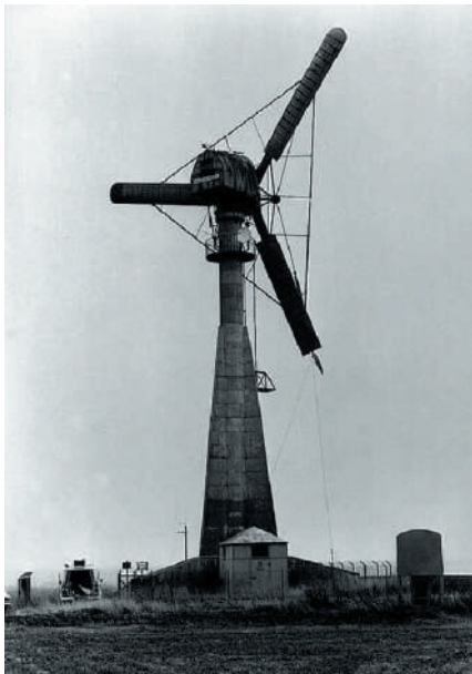
Fig. 4.23. Prima turbină construită conform „conceptului danez” de J. Juul în localitatea Gedser, Danemarca [27].
