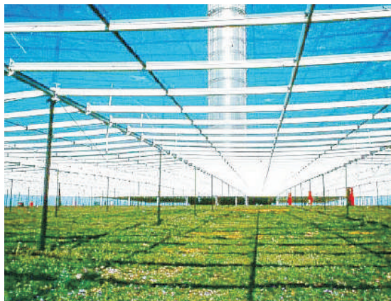
Fig. 2.43. Acoperișul din sticlă al prototipului instalației energetice din Manzanares.
