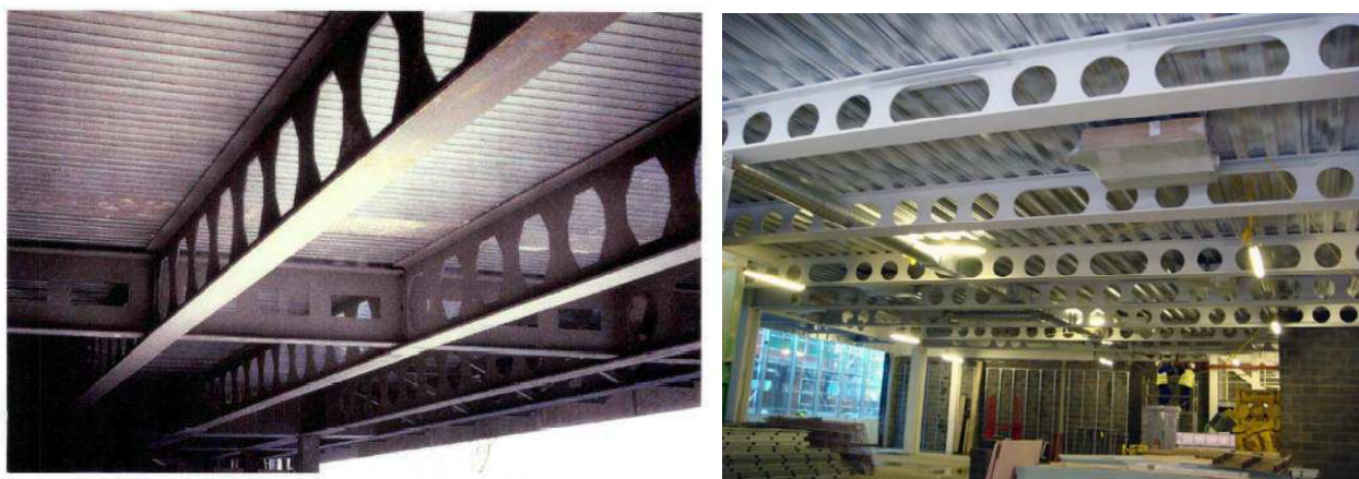
Figura 3. Grinzi ajurate folosite în construcții civile și industriale
