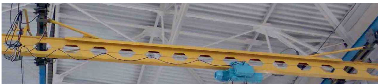
Figura 4. Grindă ajurată de rulare
