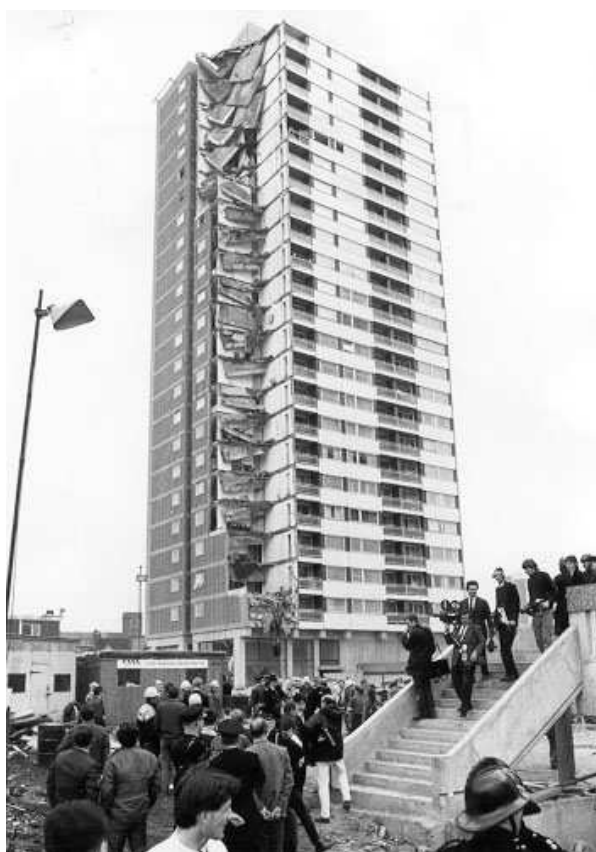
Figura 1 - Clădirea de apartamente Ronan Point, Anglia
