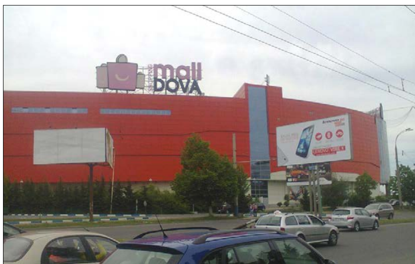
Fig. 1. Centru comercial „Malldova”, Chișinău, 2013, arhitect G. Telpiz. Foto T. Nesterova.
